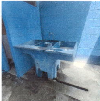
Foto 15: Sustitucion de pila de cemento de dos lavaderos area de baños
