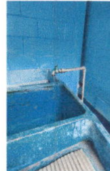
Foto 14: Sustitución de llave de corro area de baños
