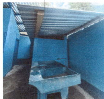
Foto 6: Sustrución de lámina por lamina troquelada aluzinc calaibre 26 en arean de baños
