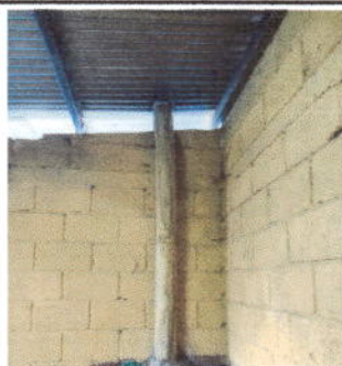
Foto 5: Sustrución de Chimenea de conrceto en area de cocina
