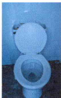
Foto 7: Sustrución de inodoro
