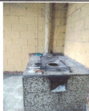
Foto 4: Sustrución de plancha de metal de 3 hornillas, Intalacion de azulejo de estufa rural area de cocina en area de cocina
