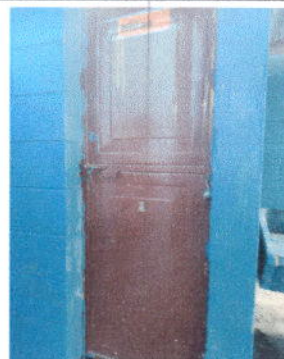
Foto 8: Sustrución de puerta en servicios sanitarios en area de baños
