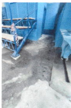
Foto 9: Reparacion de plancha de concreto de patio en area de baños
