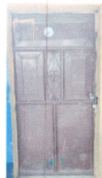
Foto 10: Sustrución de puertas area general del establecimiento
