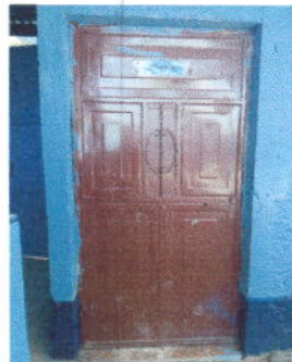
Foto 2: Sustrución de puerta en area de cocina
