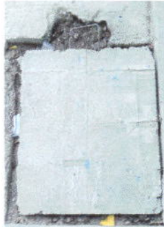
Foto 13: Reparacion de tapadera de caja en Area general del establecimiento
