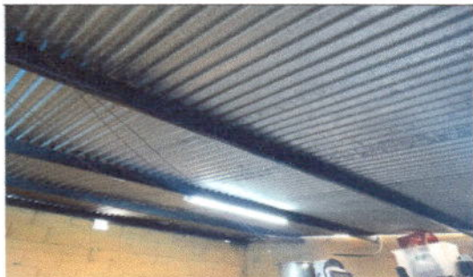
Foto 1: Sustrución de lamina, por lamina troquelada aluzinc calibre 26 en Area de cocina
