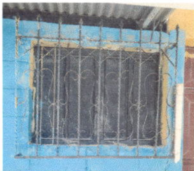
Foto 3: Sustrución de estructura de metal de ventana y sustrución de balcón de metal en area de cocina
