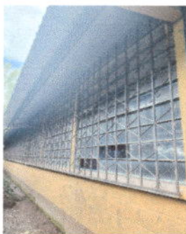
Foto 11: Sustrución de balcon de metal en area general del establecimiento
